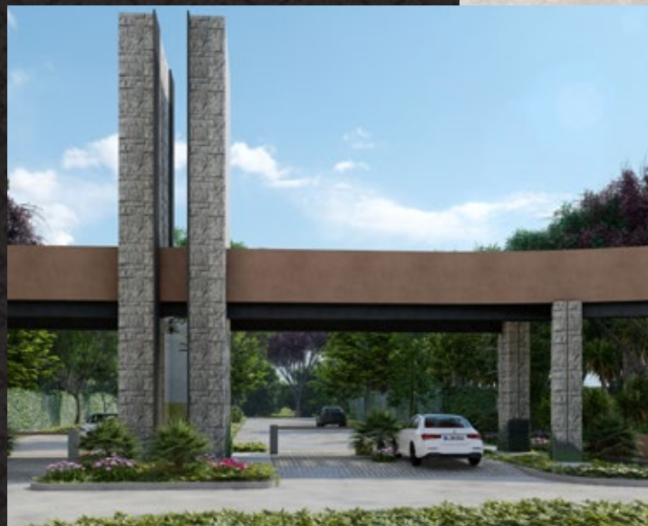
Pórtico con acceso controlado
